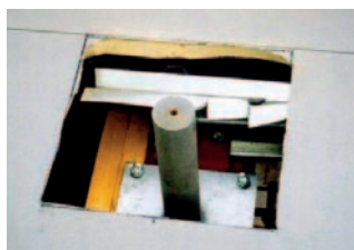
Ancoraggio tradizionale 'passante per il tetto'
